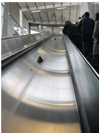
Abb. 7: Nieten Rolltreppe Bahnhof Graz
